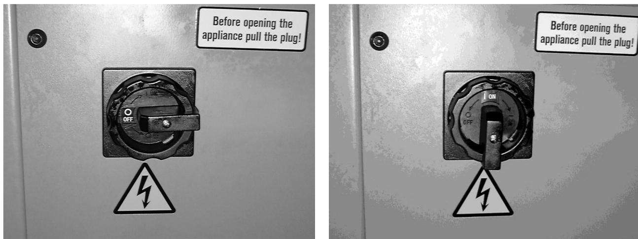
Interrupteur principal en position ARRÊT Interrupteur principal en position MARCHÉ
